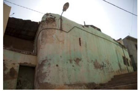
مسجد سيدي بالعلابقرية العباد حيث وضع ابن تومرت و عبدالمؤمن إحدى نصوصهما الأساسية في إقامة دولة الموحدين: المرشدة.
