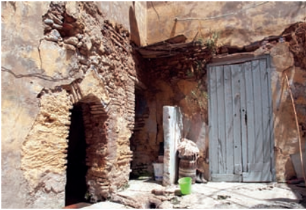
Patio de la Maison Ibn Marzuk dans la Médina de Tlemcen
