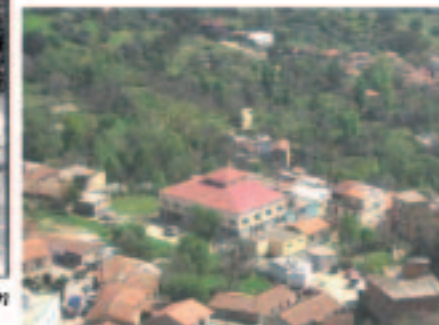
Akham Ouaman (La Maison de l'eau à Toudja) : il s'agit du grand édifice au milieu de la vue panoramique.
